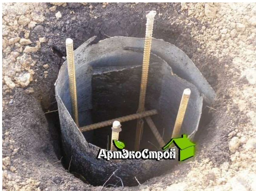
Рисунок 14 Отверстие для фундамента
